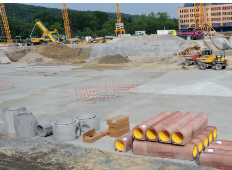
Помимо композитных труб из железобетона и пластика, компания Beton Muller также поставила в Цюрихе монолитные кольца с дном марки Perfect
