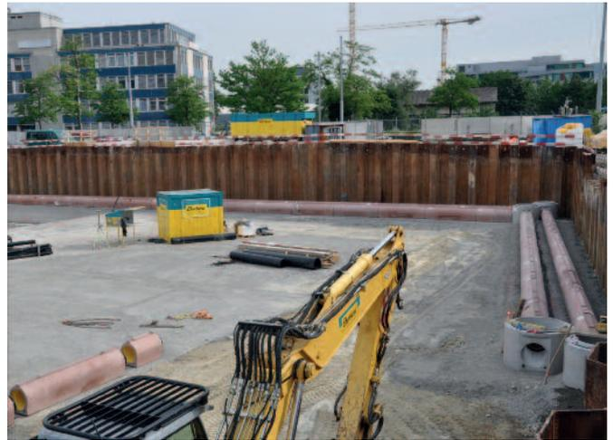
Трубы Perfect Pipe с резьбовыми соединениями позволили значительно повысить эффективность монтажных работ – укладки, засыпки, трамбовки – в ходе реализации вышеописанного проекта в Цюрихе
