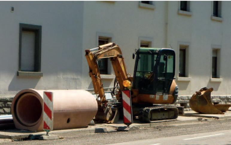
При строительстве нового здания в Ахерне / Баден-Вюртемберг были уложены железобетонные трубы с плоской подошвой диаметром DN800, некоторые из них снабжены отверстиями для подключения приточных труб
