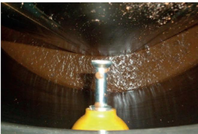
Благодаря заливке подвижным бетоном закладные детали полностью покрываются бетонной смесью
